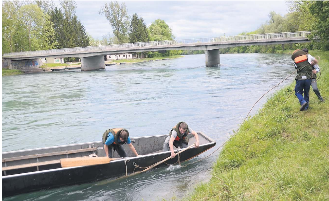
Bootsfährenbau verlangt viel Kraft: Erst muss das Stahlseil über den Fluss gezogen werden. (Bilder Martin Mullis)
