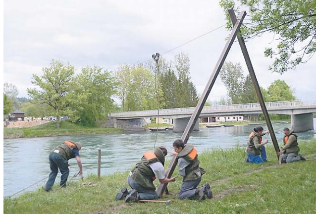
Jeder Handgriff muss sitzen: Das «Zweibein» für das Seil und die Lauftrosse wird verankert.
